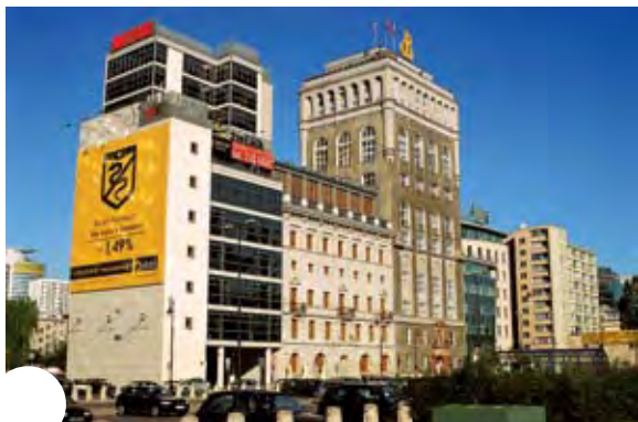
Siedziba FWPN po rozbudowie, drugi od lewej zabytkowy budynek z 1904 roku
